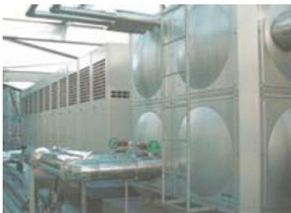
屋上に設置された排熱回収型ヒートポンプ(左)と貯湯槽(右)
